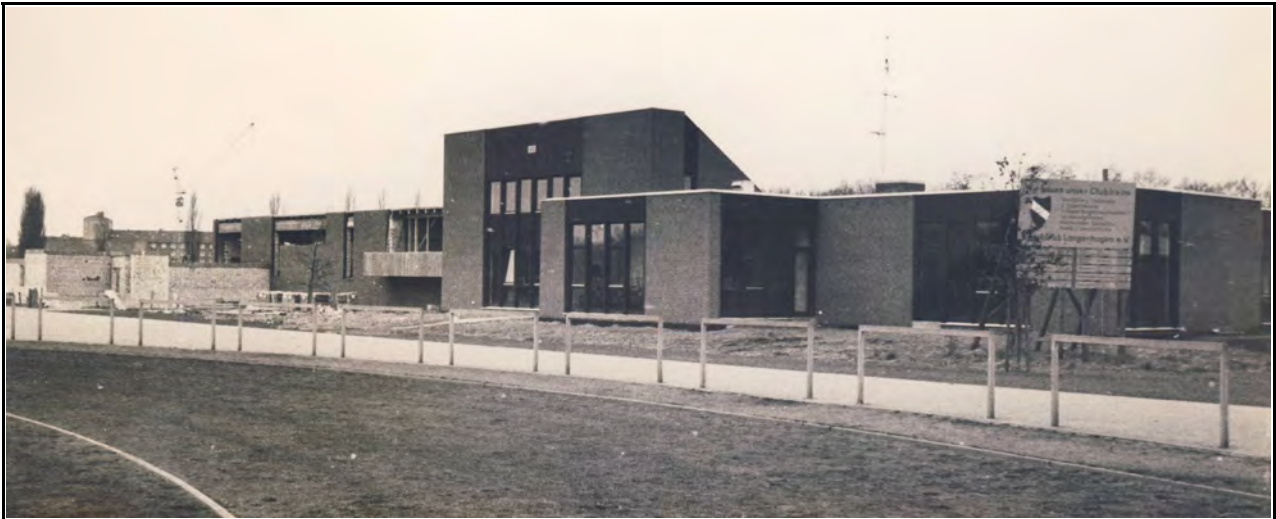
Das neue Clubhaus kurz vor der Fertigstellung; Grundsteinlegung erfolgte am 8. Dez. 1975, Einweihung am 10. Dez. 1976; Aufnahme von Süden, von der Sportplatzseite aus.
